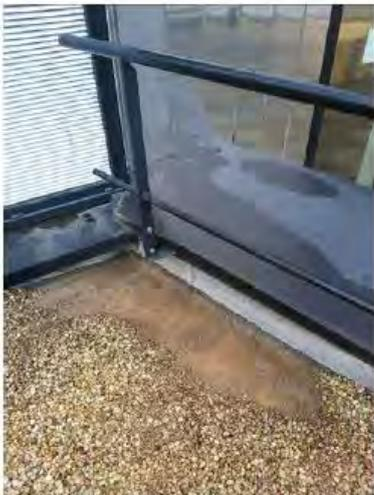
RELEVE CLOQUE A REPENDRE EN FLASHING
