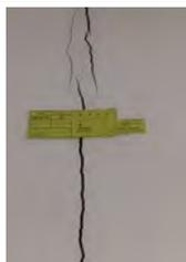
Une fissure assez importante est apparue dans le couloir d'accès aux vestiaires. Une jauge de surveillance a été installée.
