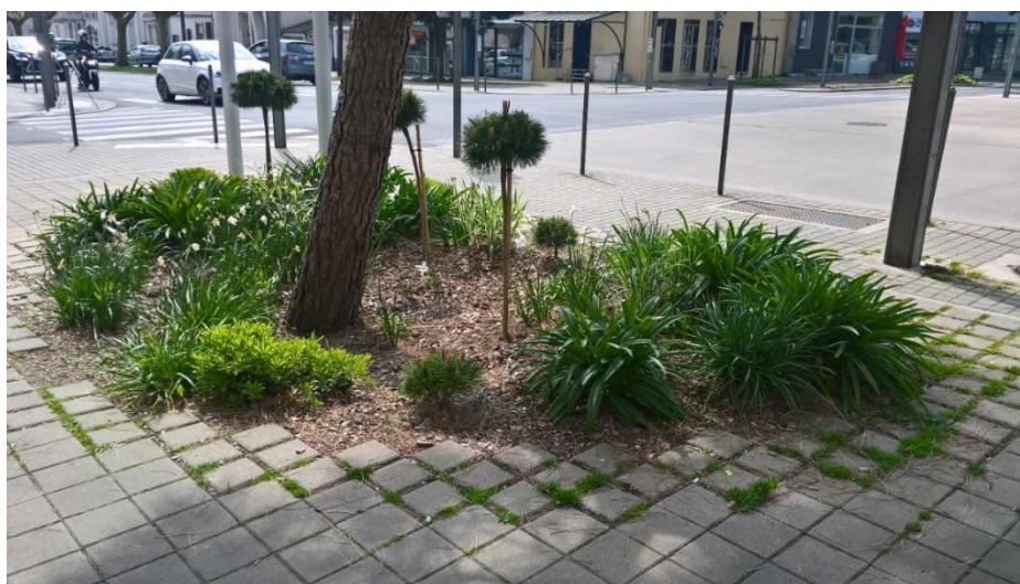
Figure 13 : Photo d'un exemple de délimitation d'une fosse à arbre – ARNOURLD W.
