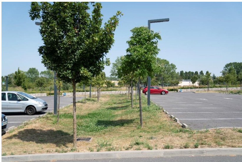
Figure 7 : Noue connectée par surverse à la structure réservoir de la voirie - AERM
