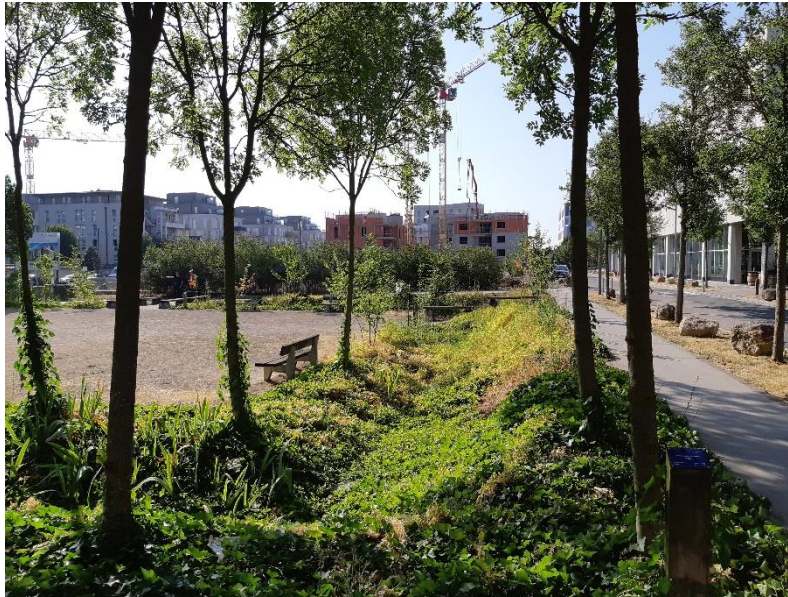
Figure 6 : Noue d'infiltration, Nancy (54) - AERM
